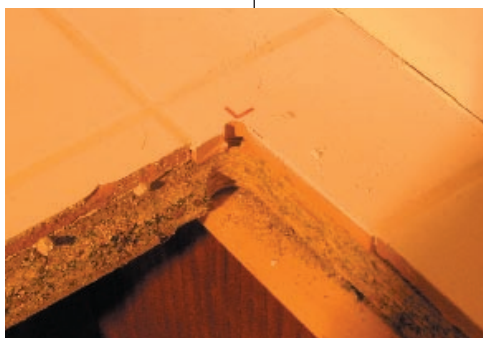
Sotto da sinistra: particolare del sandwich con evidente la fessura sulla zona di giunzione; altro particolare; particolare della microfessurazione accentuata con la grafite e particolare della fessura sulla congiunzione piano-parete.
