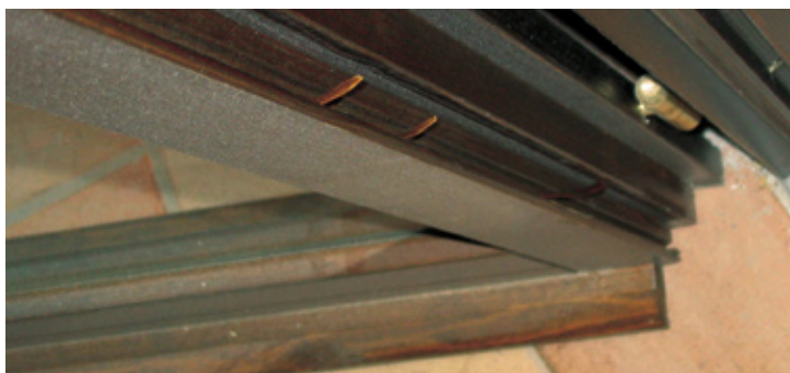
Il difetto come si presenta su di una minoranza di manufatti, con evidente rottura di una parte dell'anello, distaccatosi dal montante.
