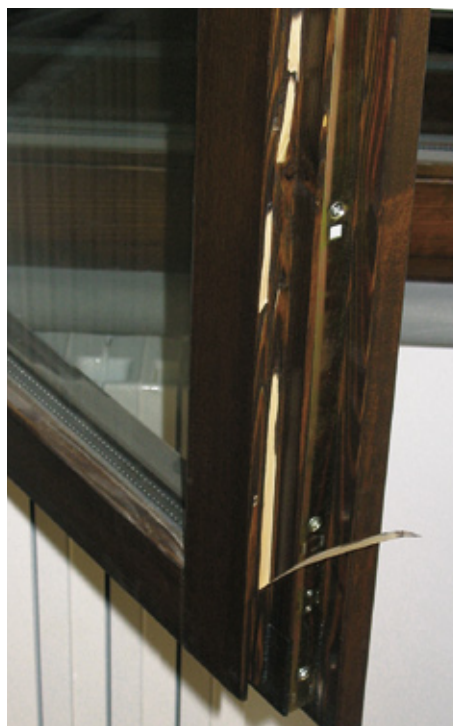
Il difetto come si presenta su di una minoranza di manufatti, con evidente rottura di una parte dell'anello, distaccatosi dal montante.
